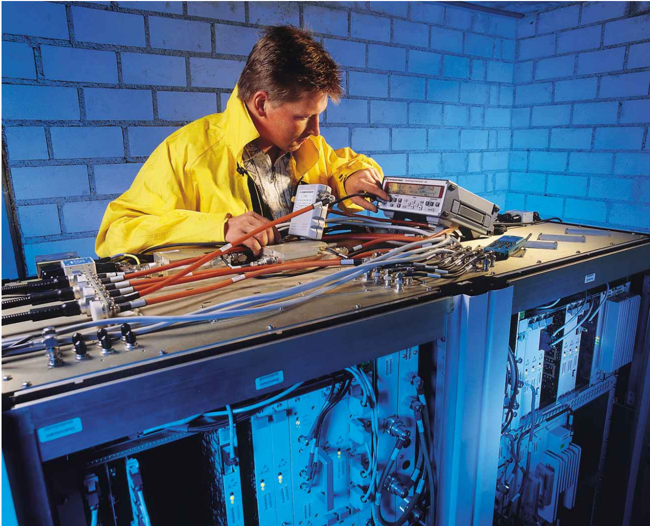
NRT bei der Installation einer Mobilfunk-Basisstation (Foto 42667)
